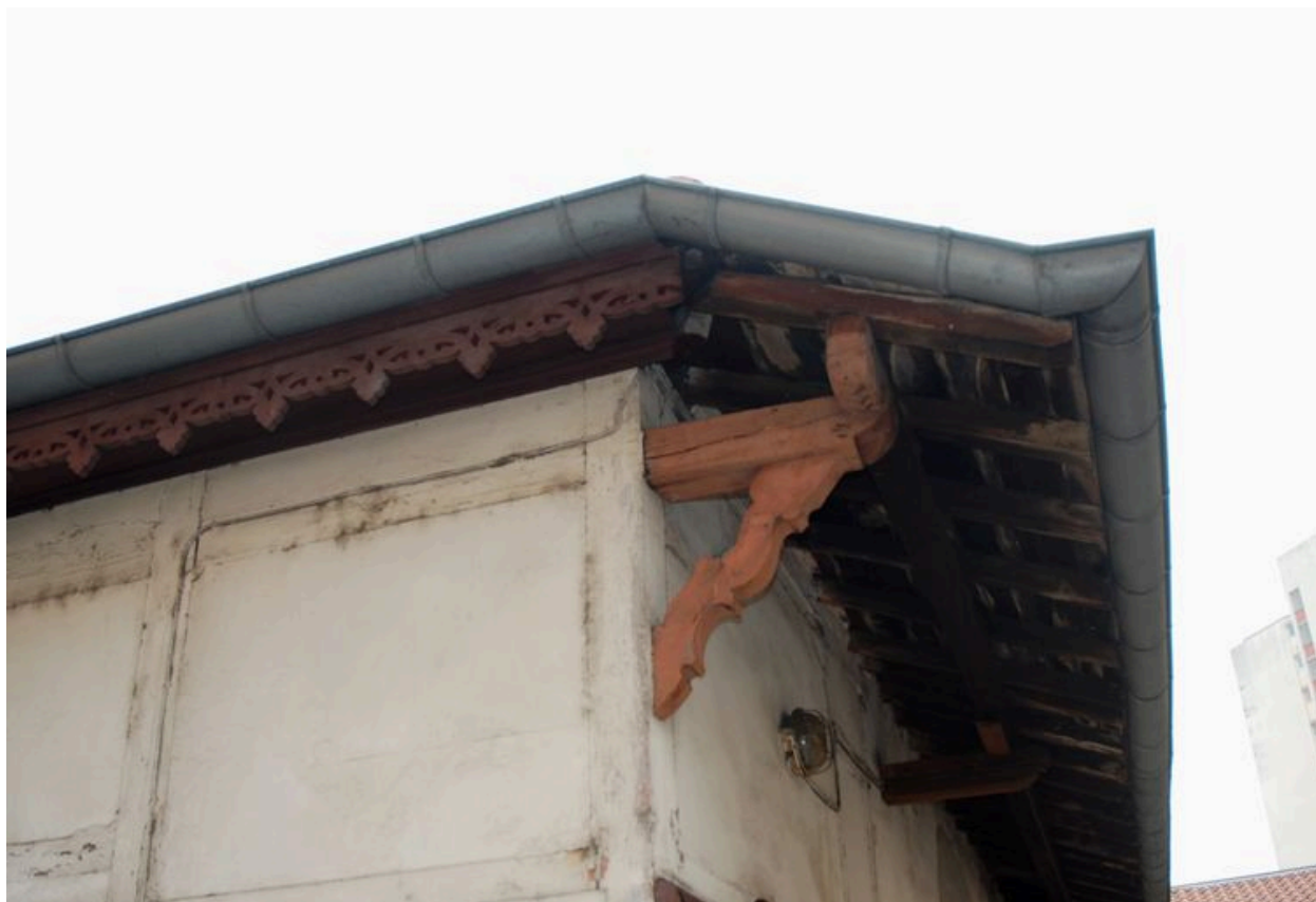
Entrepôts, détail de l'avant-toit
