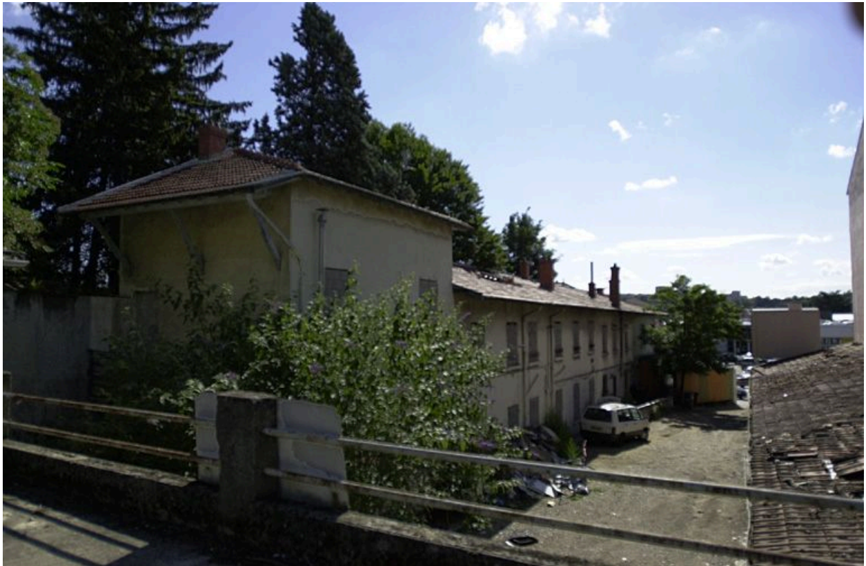
Vue générale depuis le boulevard de la Duchère
