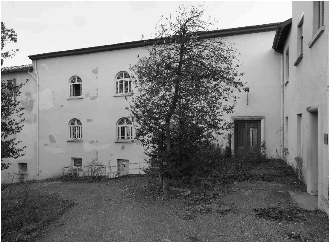
Bâtiment sud, dit "les Platanes", élévation occidentale
