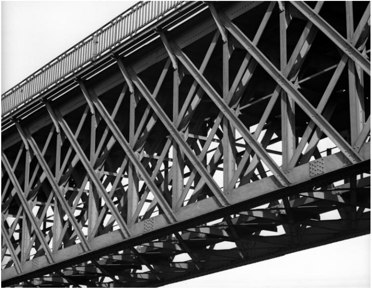
Détail de la structure métallique du tablier.
