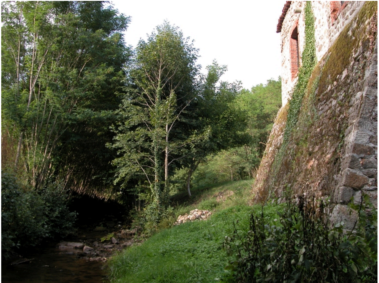
Vue du Vizézy au pied du moulin, côté ouest.
