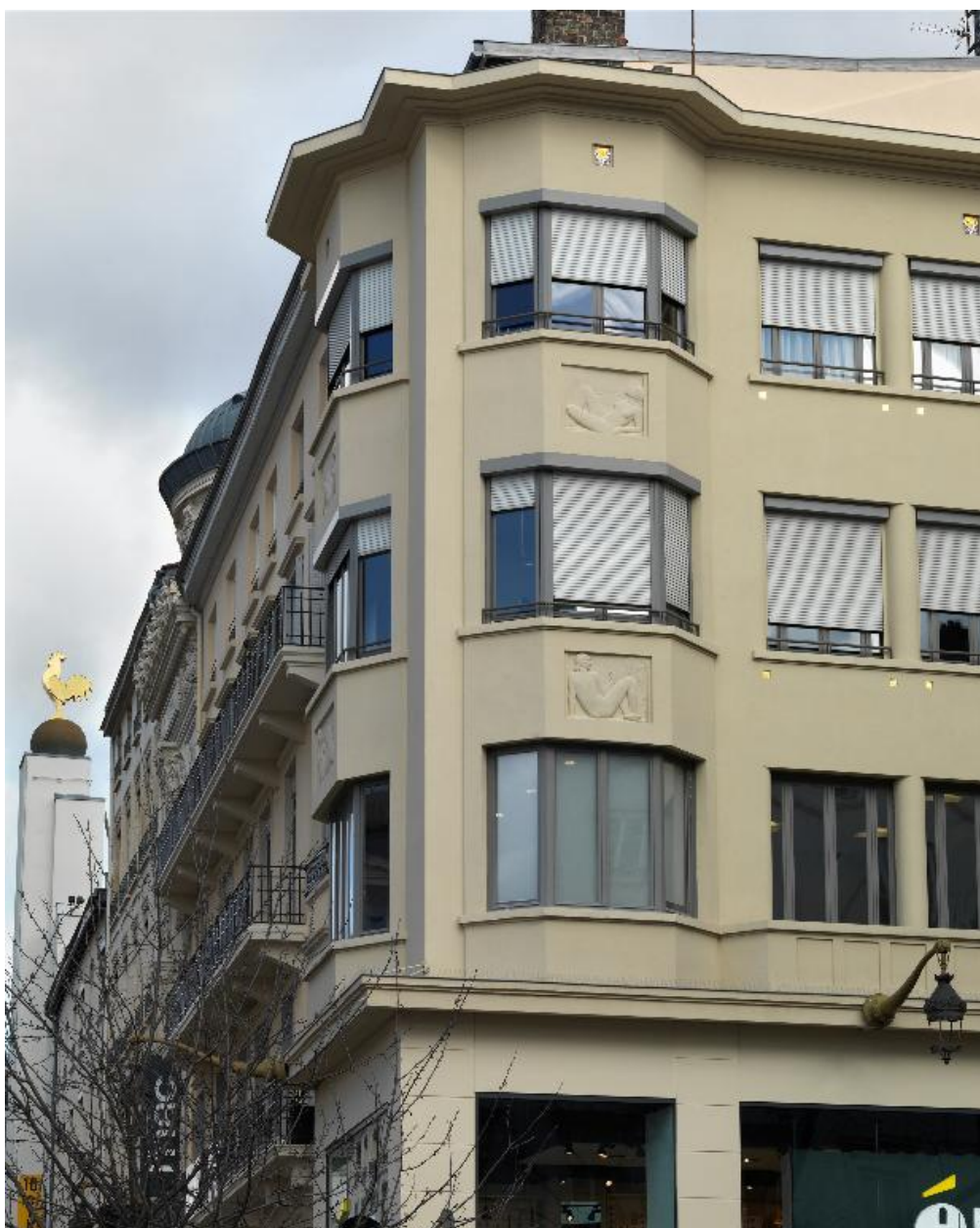
Elévation principale, détail
