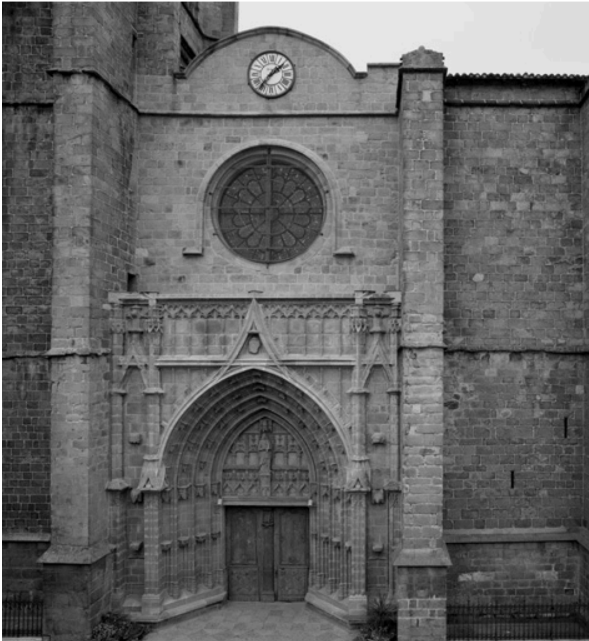
Détail de la partie centrale de la façade occidentale.
