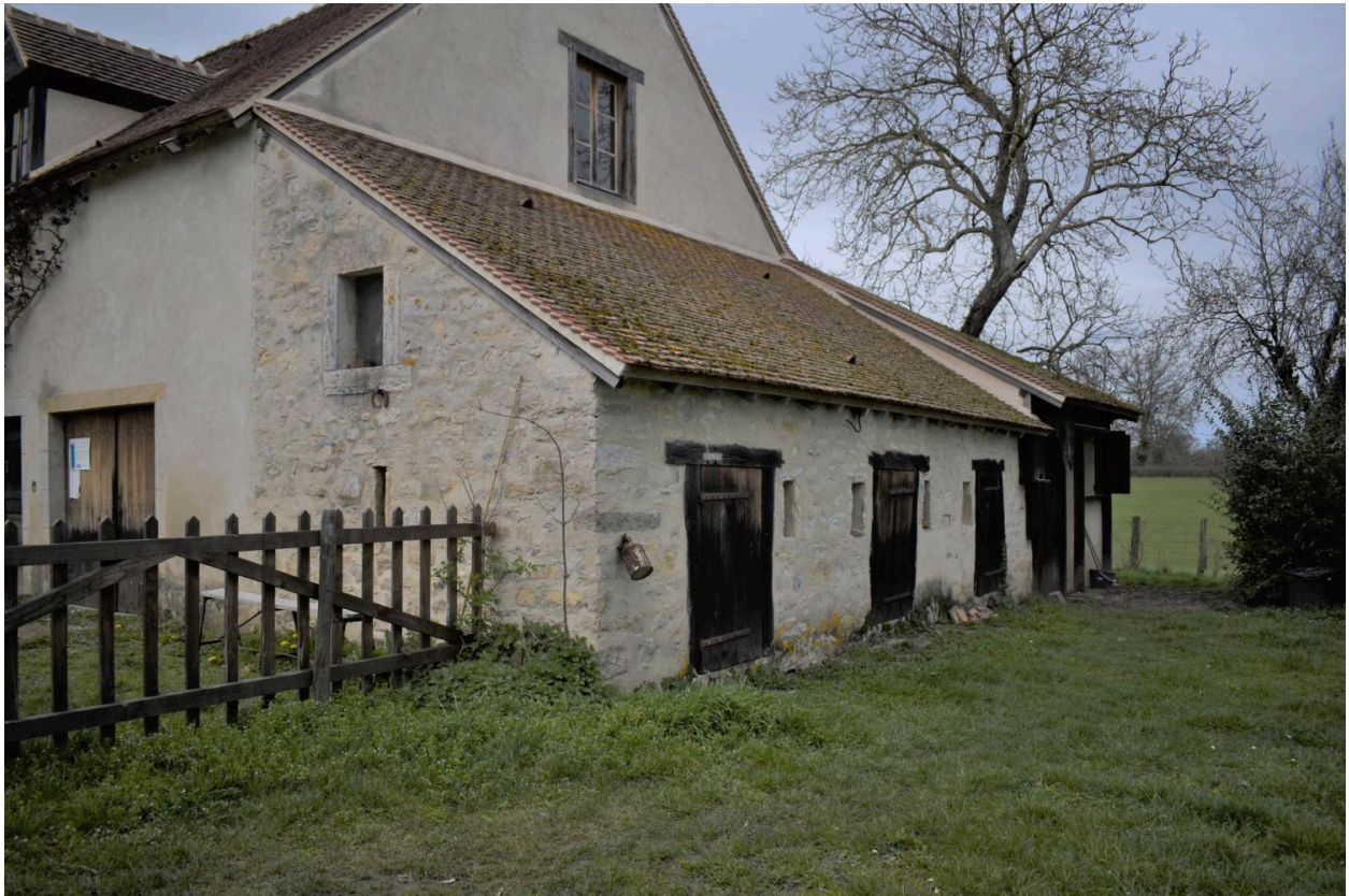
Vue de l'appentis de la grange à l'est (ancienne bergerie?)
