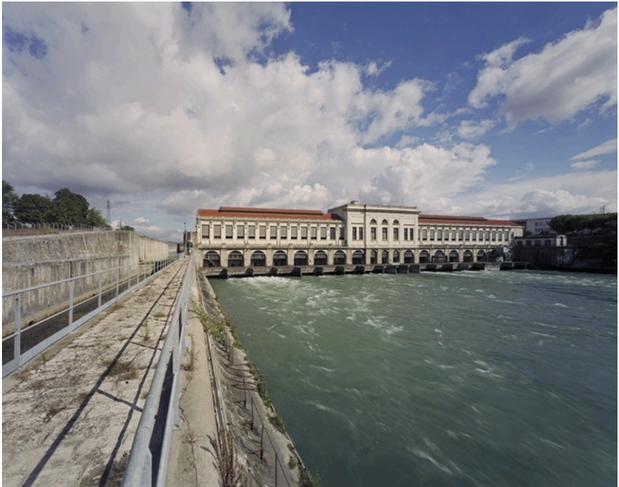
Vue générale, façade aval (est)
