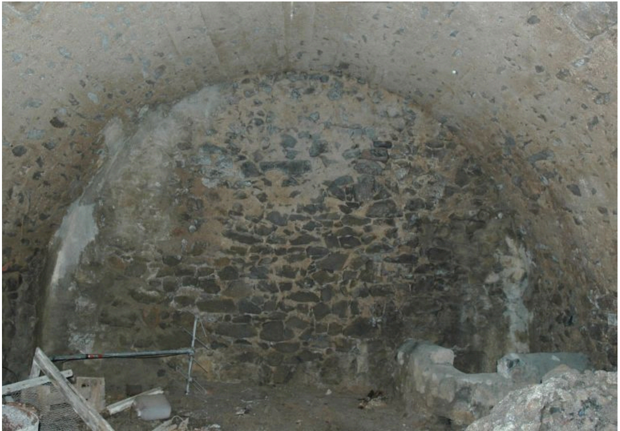
Cave en berceau en plein-cintre.
