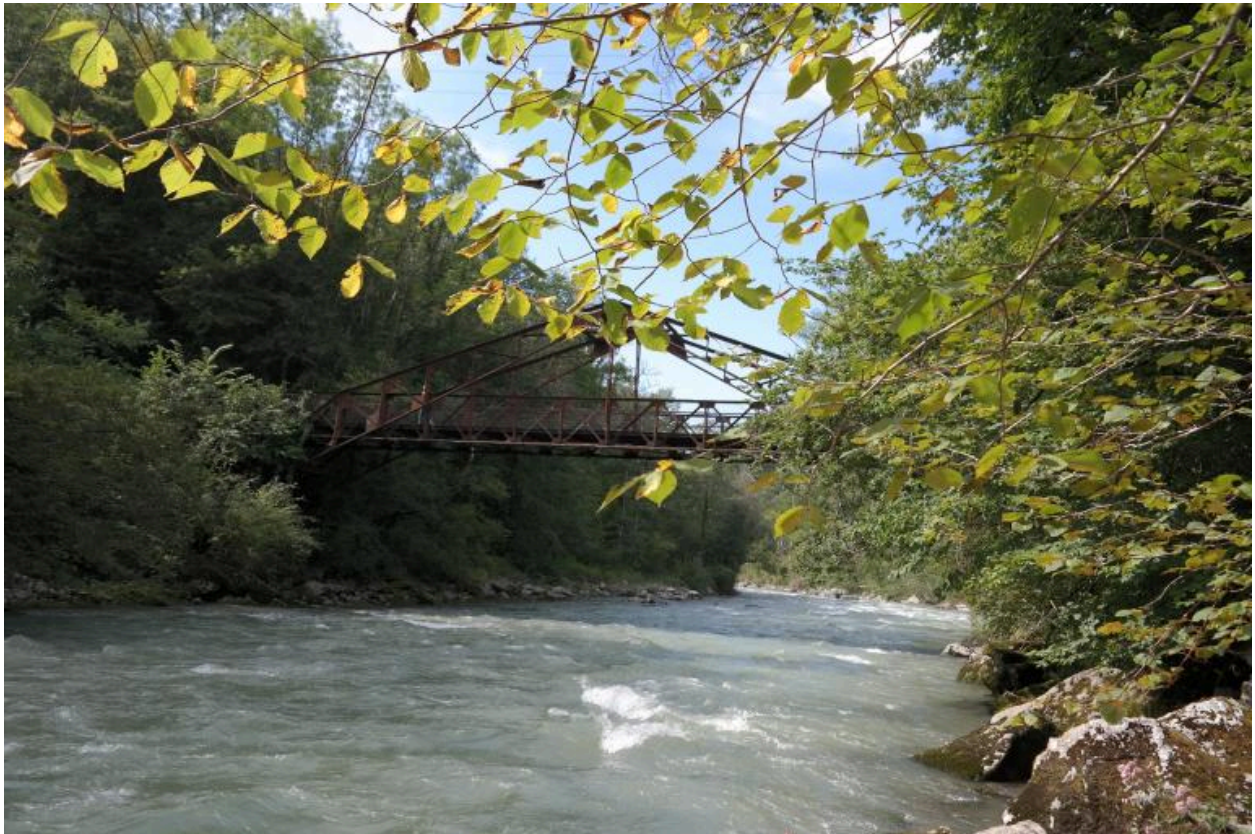
Passerelle de la plâtrière d'Armoy, vue de la face aval
