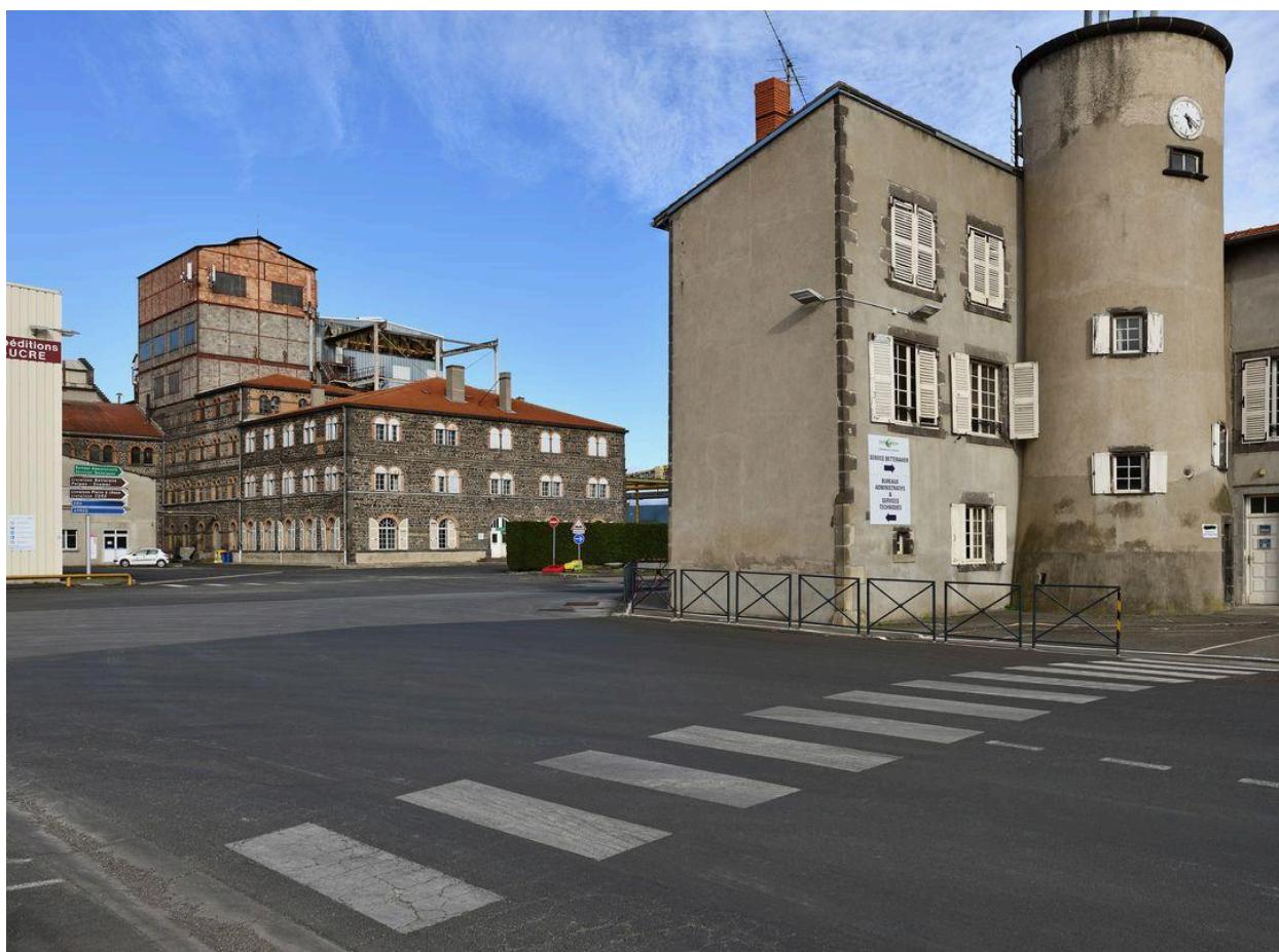
Vue d'ensemble des différents ateliers et bureaux
