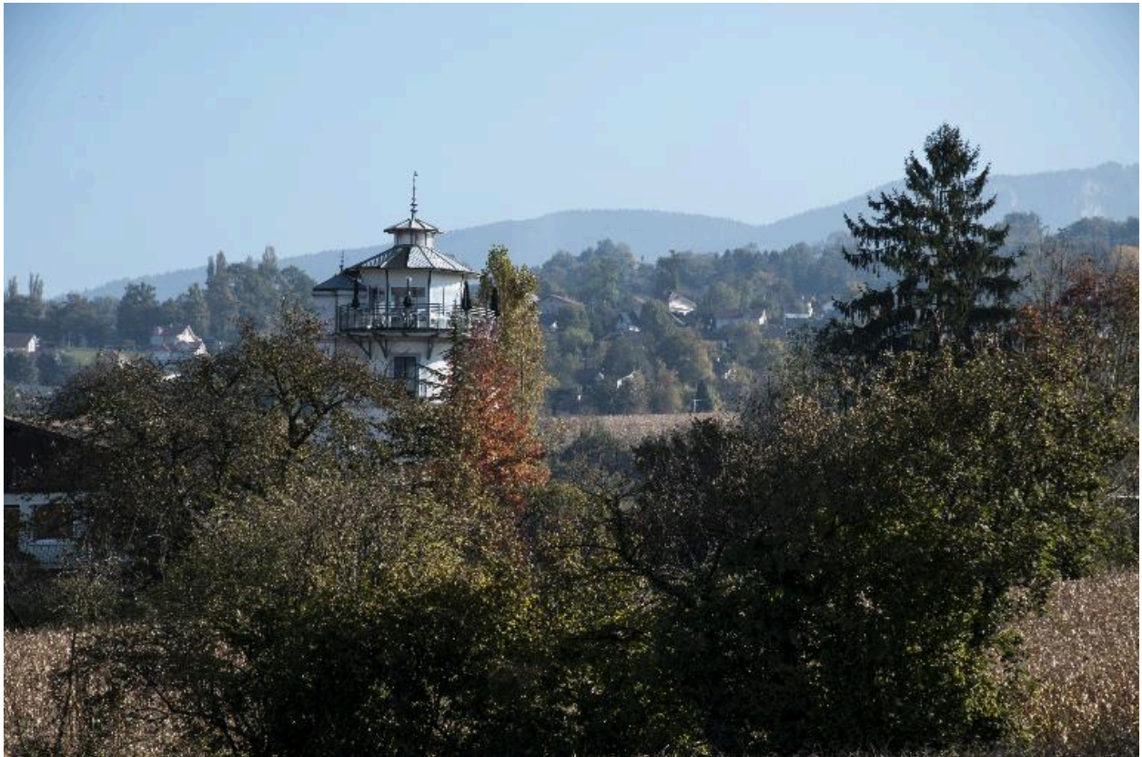
La tour, vue depuis l'école Saint-Simond à l'ouest
