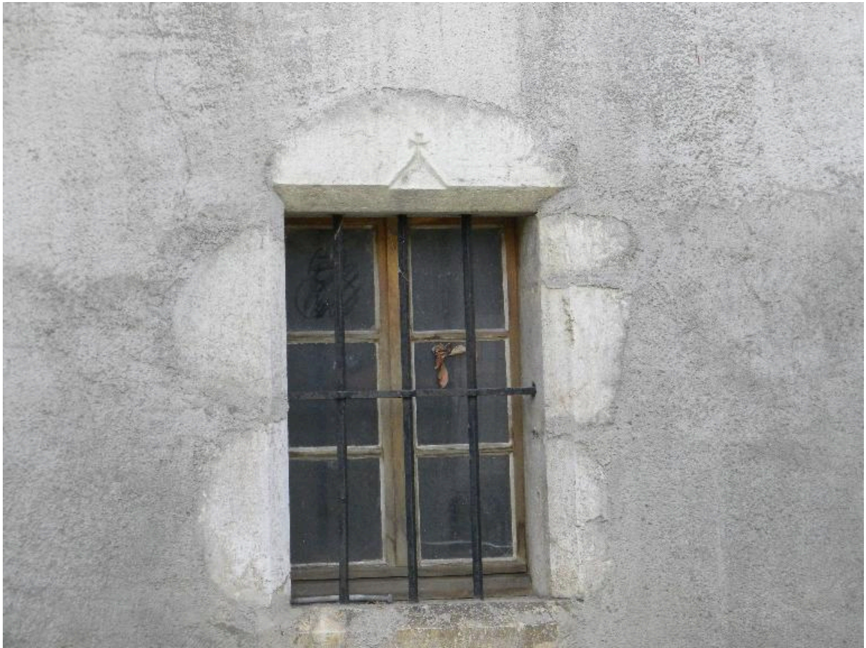
Détail d'un encadrement de fenêtre en pignon est.
