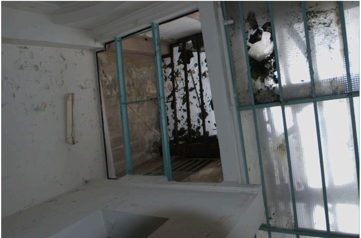
Détail éclairage zénithal (verrière)
