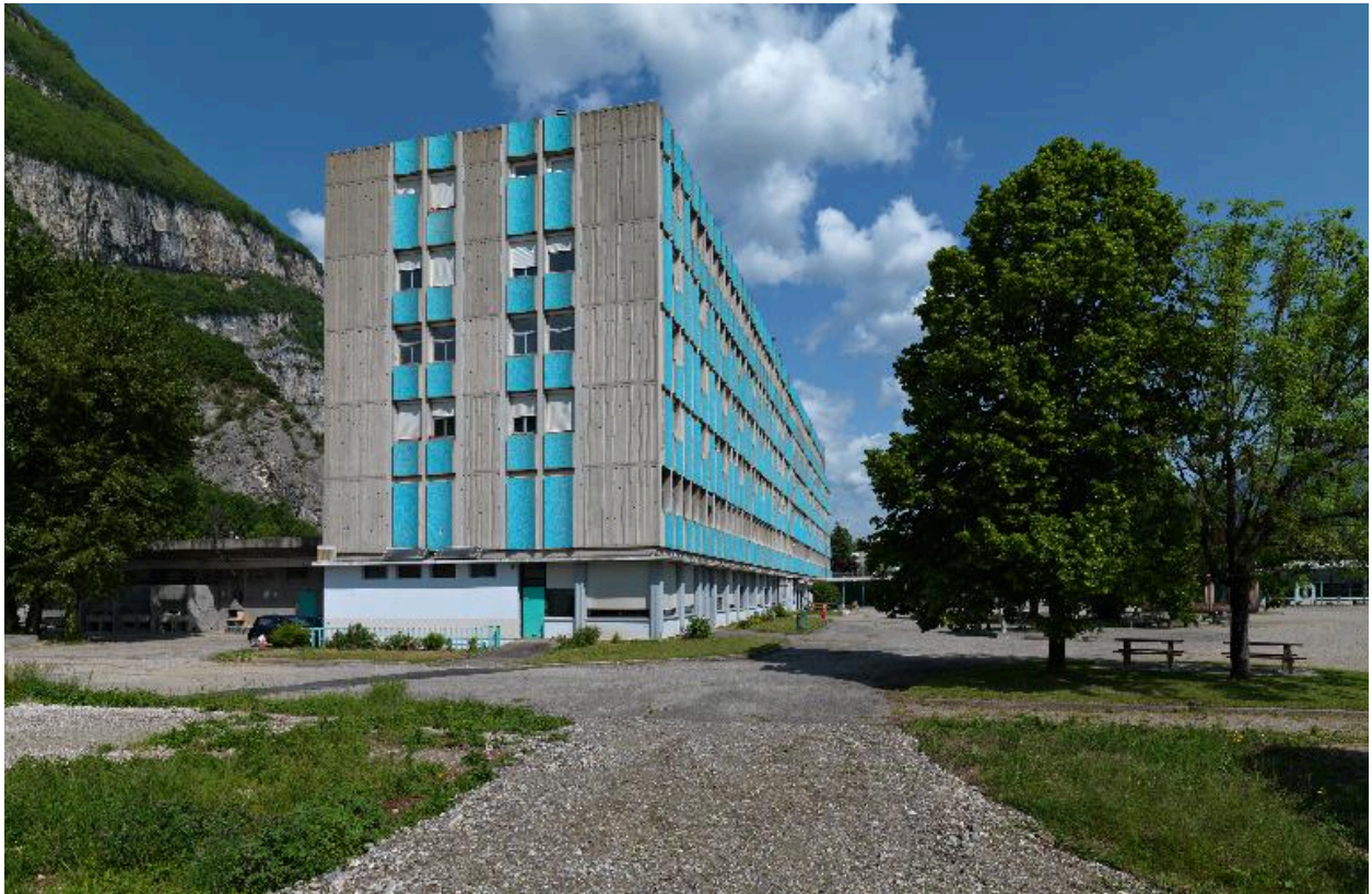
Internat, vue d'ensemble depuis le sud
