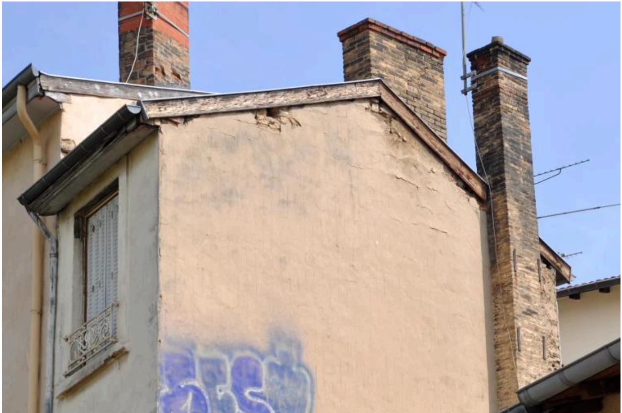
7 rue des Tanneurs, pisé visible dans le mur pignon
