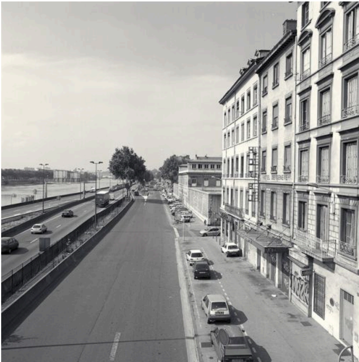
Vue d'ensemble du quai depuis le viaduc ferroviaire au nord
