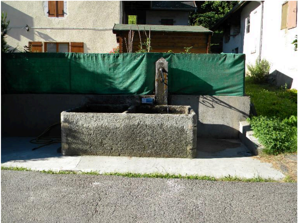
Vue générale du bassin.
