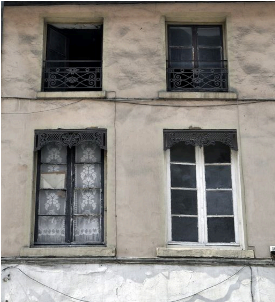
Détail des ouvertures sur rue
