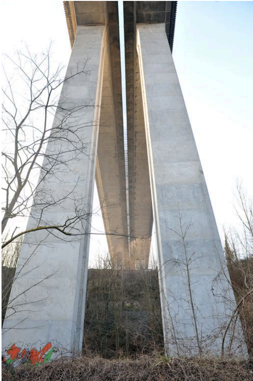
Dessous du tablier et piles, vue de détail (depuis la rive droite)
