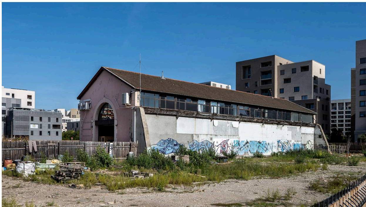
Vue sud-est de la halle des Ets Weitz dite des Girondins
