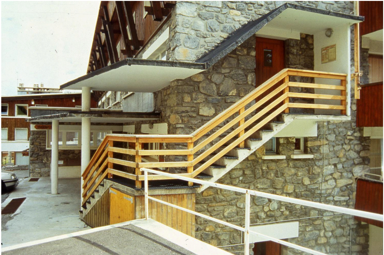
Un escalier de distribution extérieur
