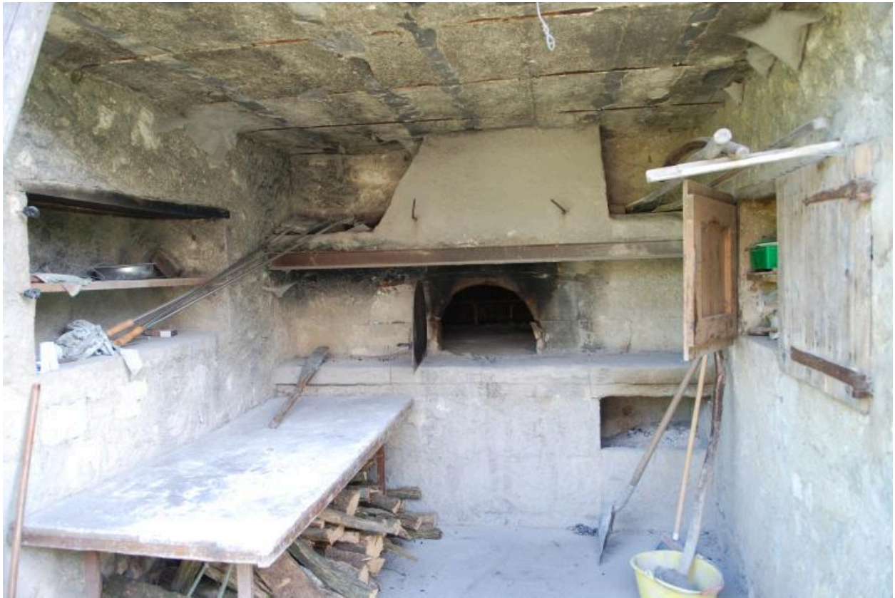
Vue intérieure du fournil.
