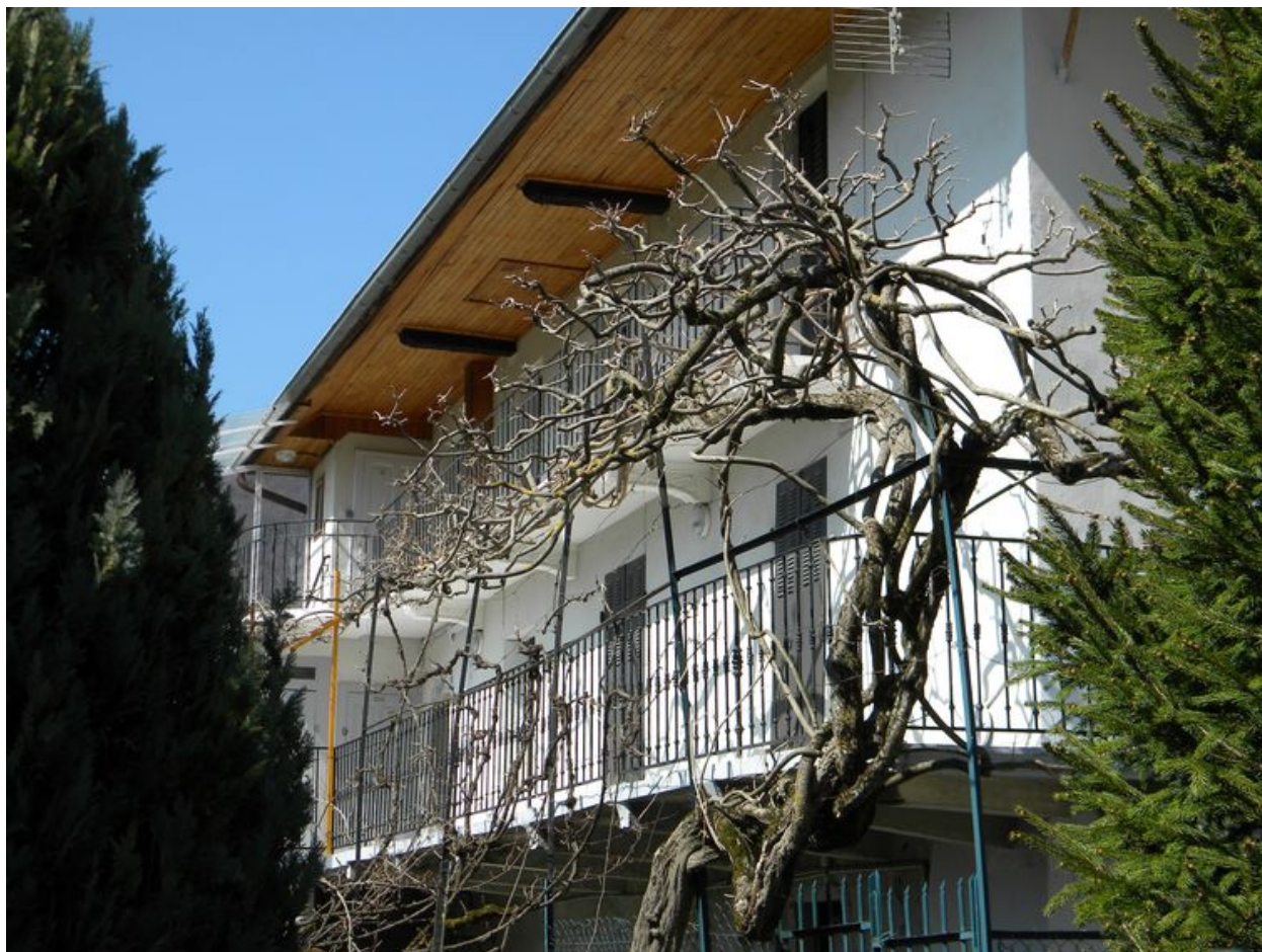
Façade sud d'une ancienne ferme très modifiée (A2 453,455, 1436, 1698).
