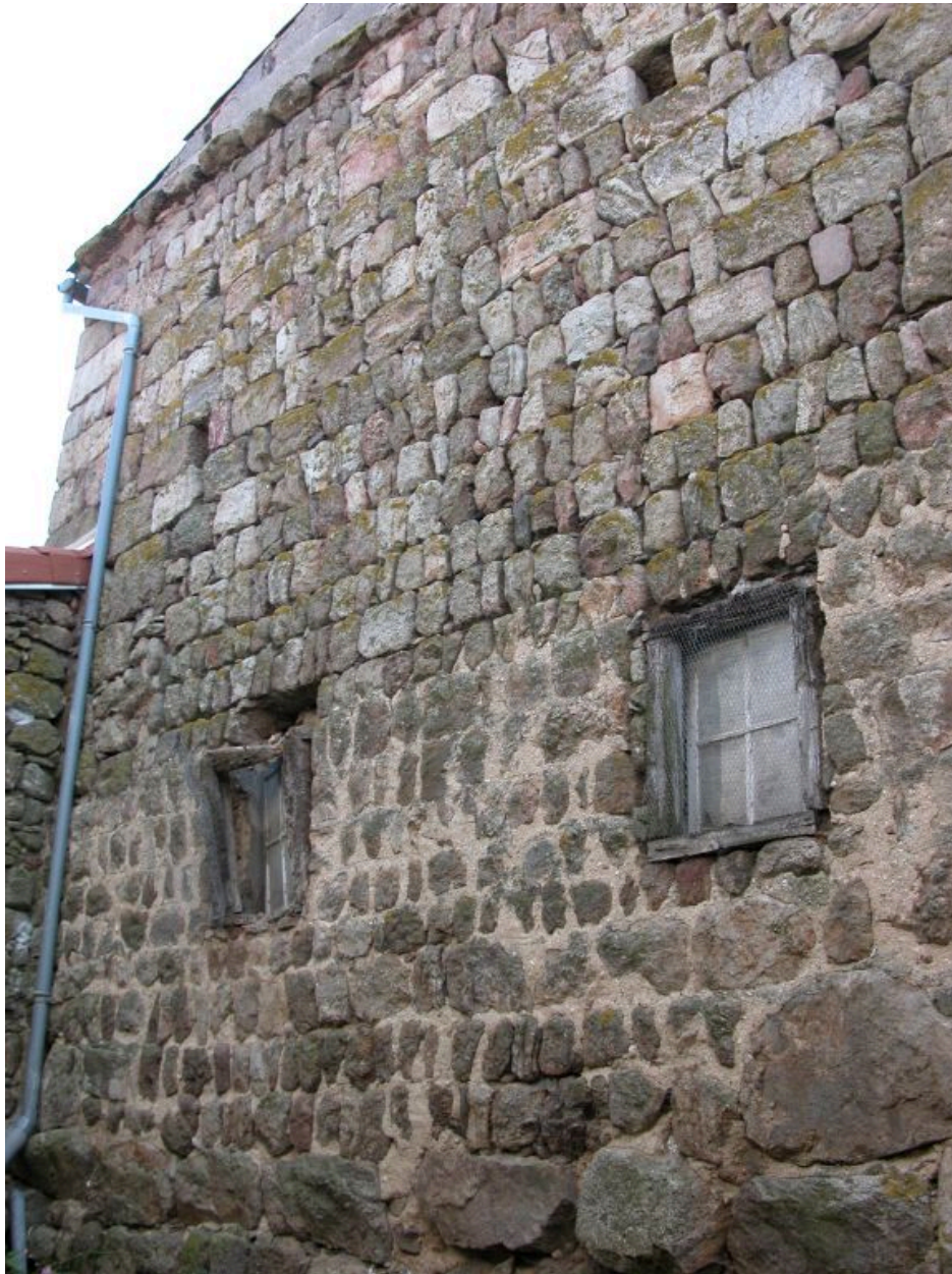
Vue du mur pignon (sud) de la grange-étable nord-ouest : appareillage en moellon posé sur chant, corniche en granite.
