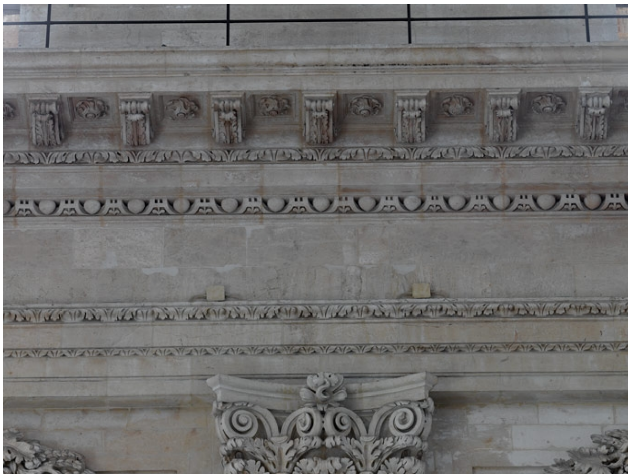
Frises et corniche supportant la galerie supérieure
