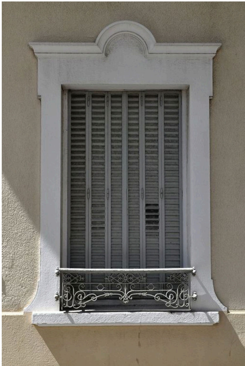
Baie centrale du rez-de-chaussée
