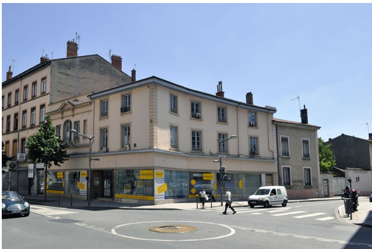
Vue générale nord-est
