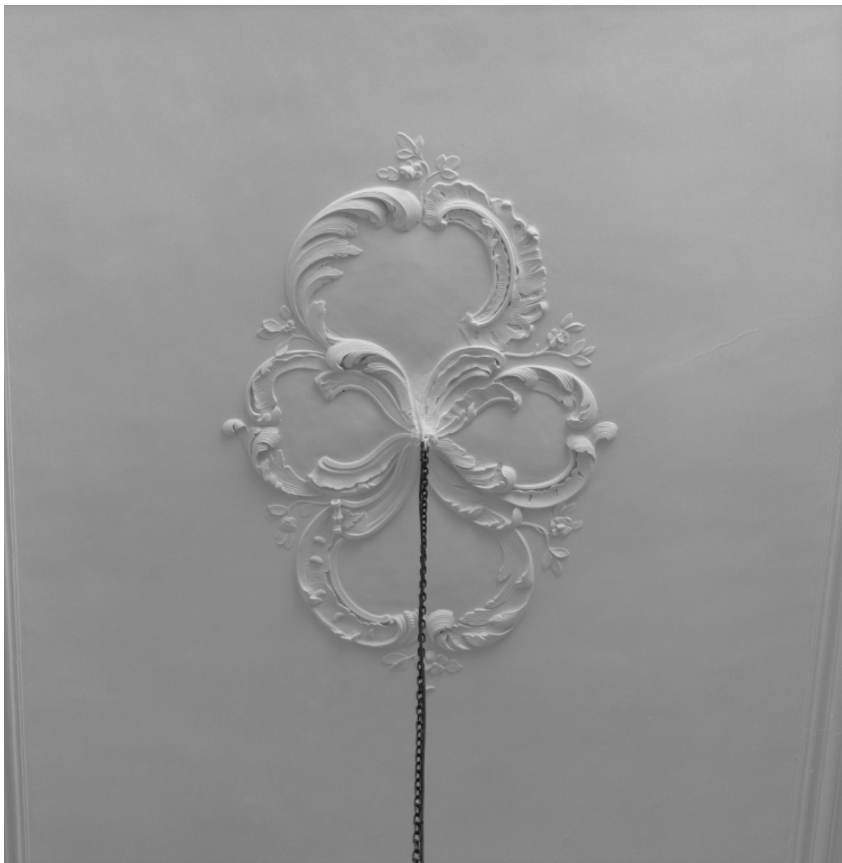
Premier étage, cage d'escalier : détail de la rosace en stuc du plafond.
