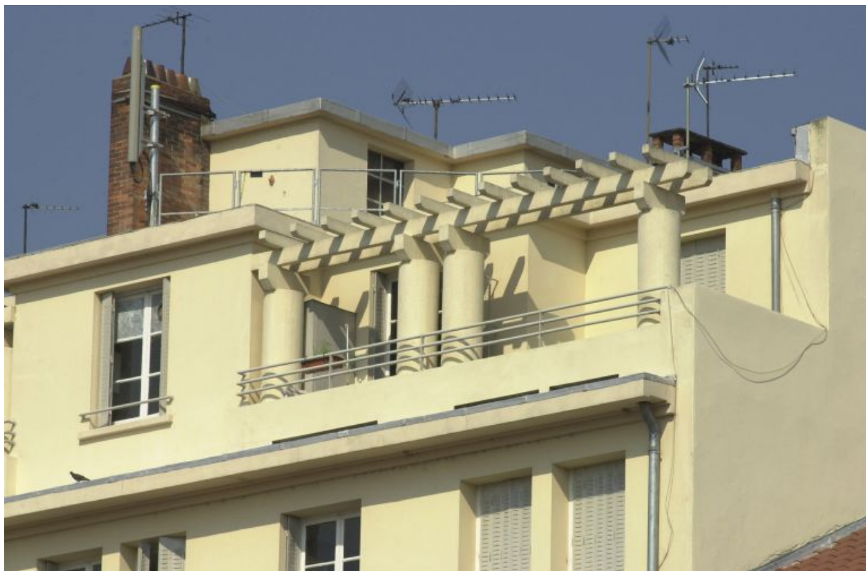
Détail de la pergola rue Smith
