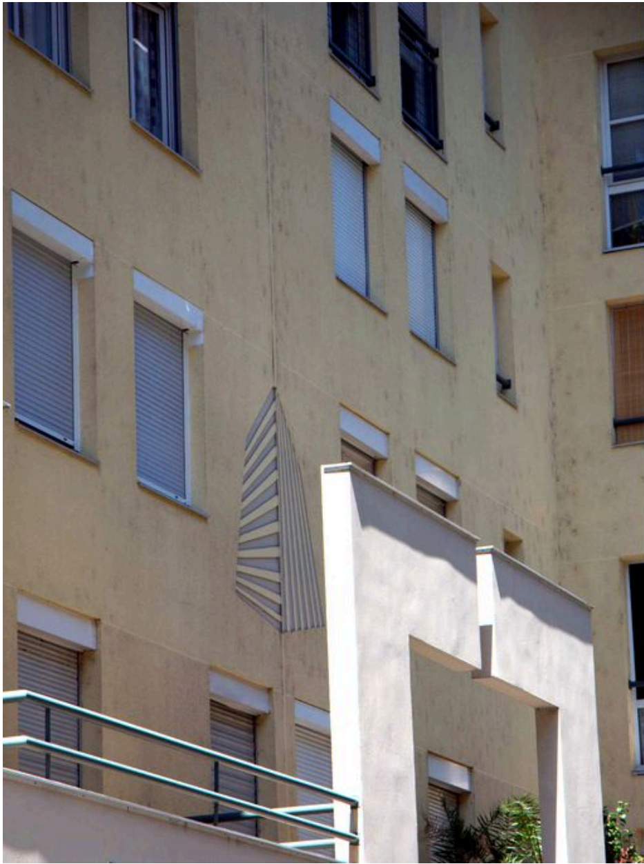
Détail du décor de la façade
