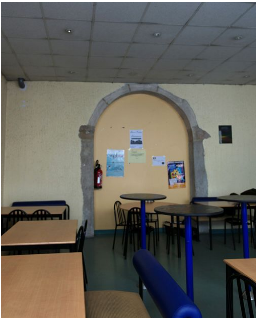
Rez-de-chaussée, salle nord, ancienne ouverture murée.
