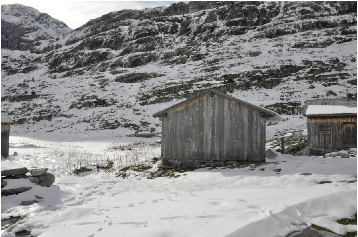
Vue du mur pignon est à la fin de l'hiver
