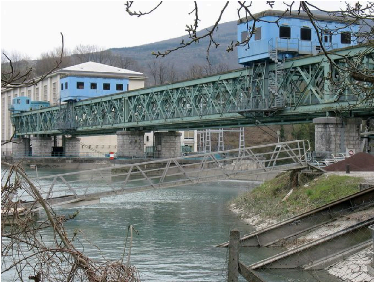
Vue de l'usine-barrage, face amont (nord), depuis la rive droite
