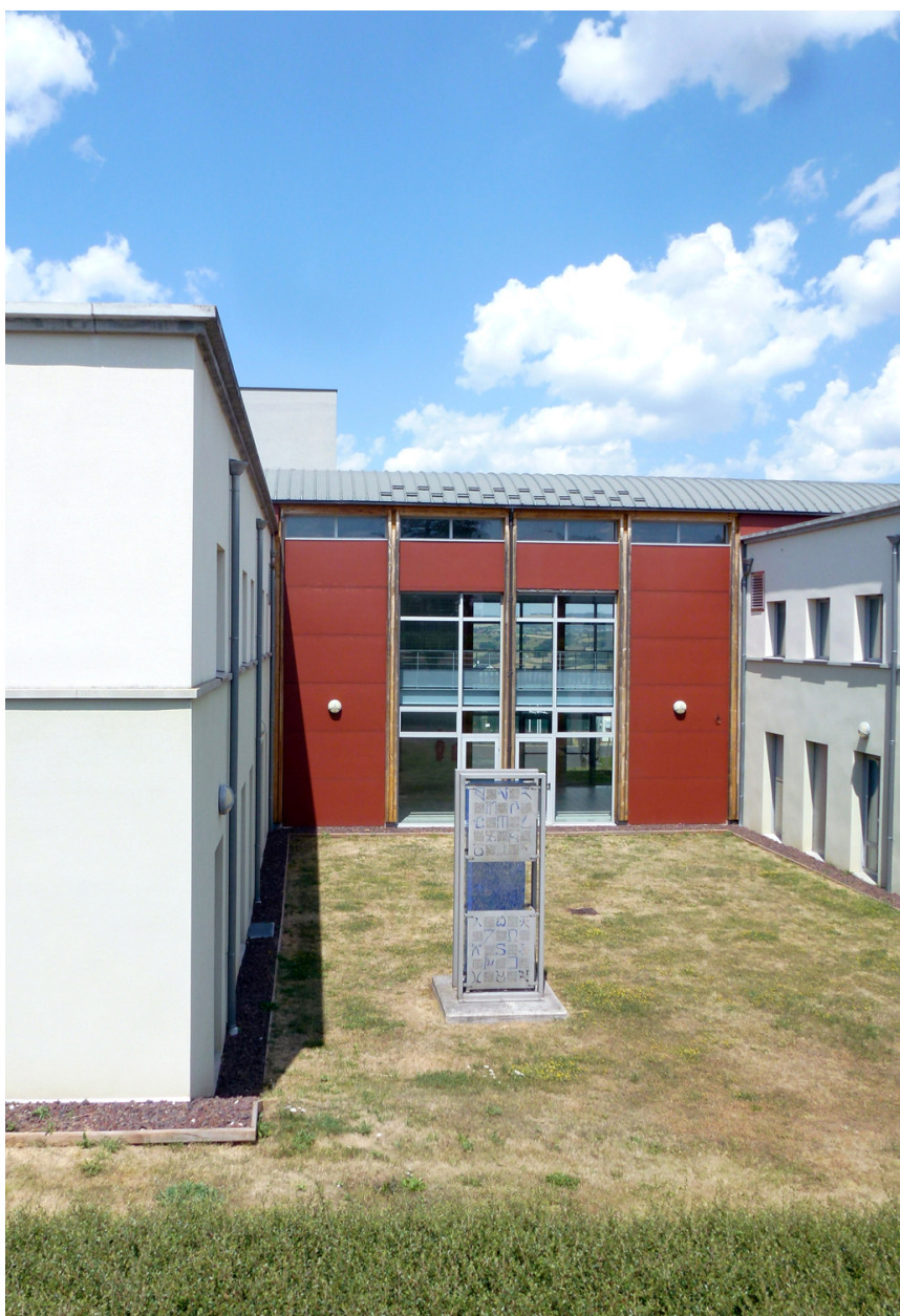
Installation n°2, vue d'ensemble
