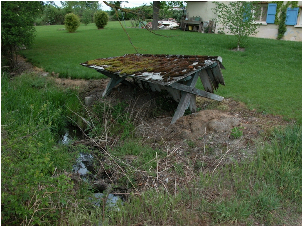
Vestiges du lavoir des Piars (? 1987 C2 254).
