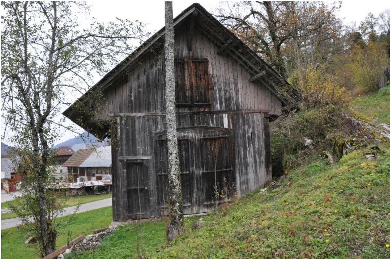
Pignon sud du bâtiment.
