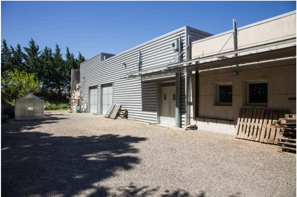
Station de grainage : façade sud
