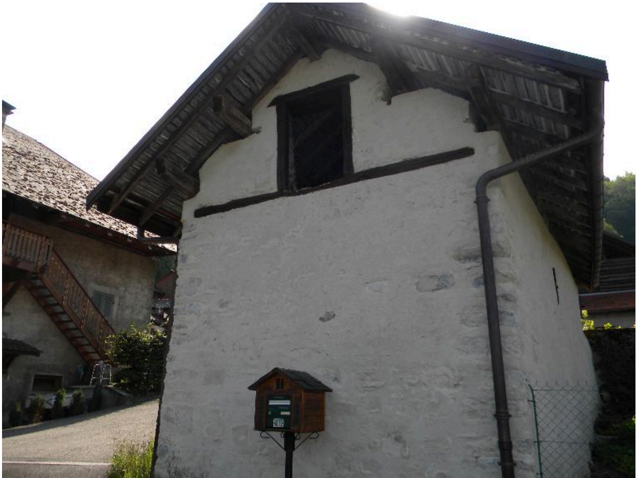
Vue de la façade arrière
