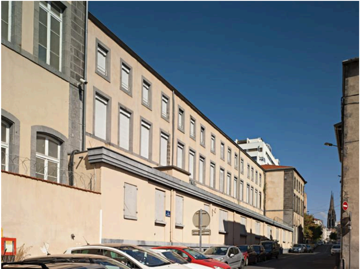
Hôtel-Dieu de Clermont-Ferrand. L'hôtel-Dieu, premier corps de bâtiment oriental, façade orientale vue du sud-est (rue Meyrand-des-Pradeaux).
