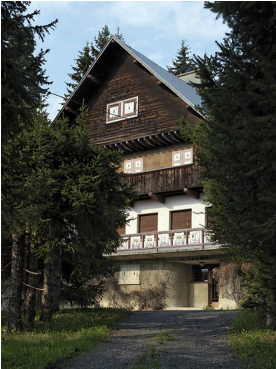
Élévation antérieure, à l'ouest
