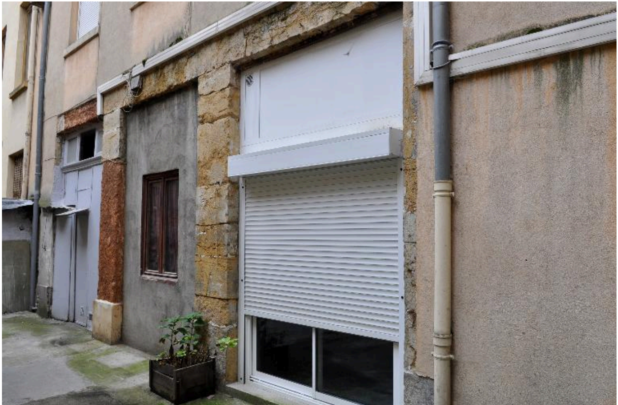
Elévation sur cour, ouvertures du rez-de-chaussée
