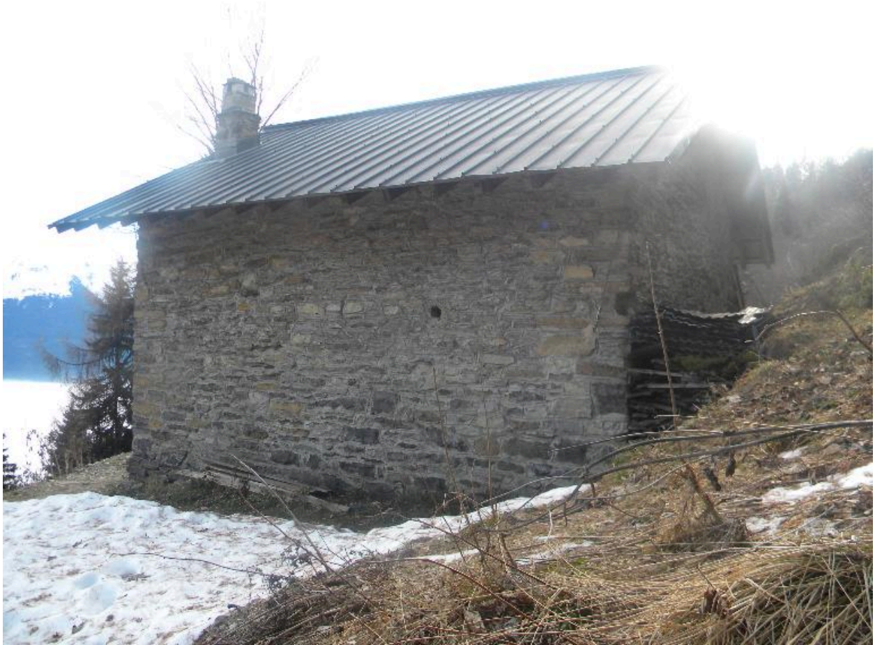
Vue de la face bord du bâtiment nord.
