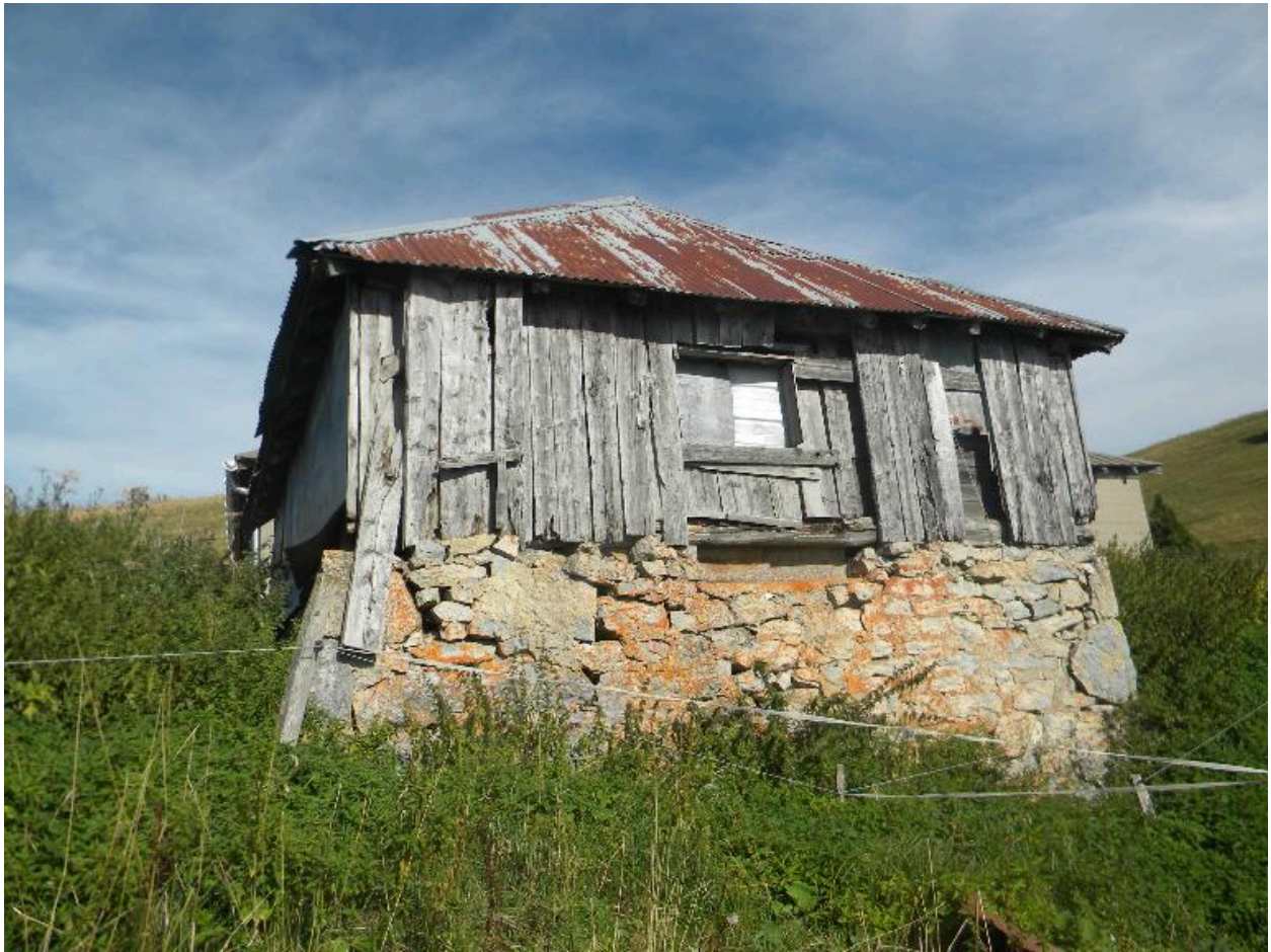
Vue du pignon ouest de l'ancienne étable.
