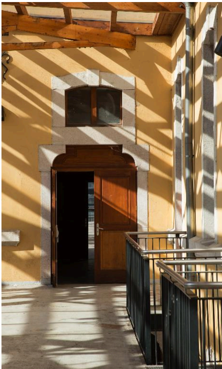
Cour 2 : galerie, passage sur R+1
