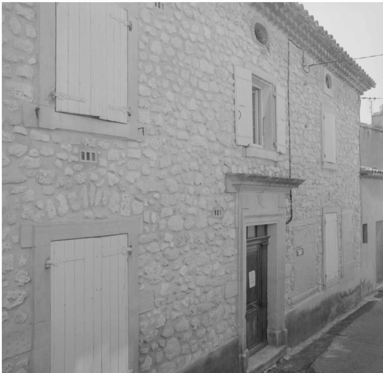
Façade sur la Grande rue, vue partielle.
