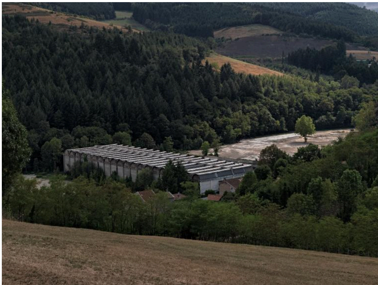
Vue d'ensemble du site avec une partie démolie.
