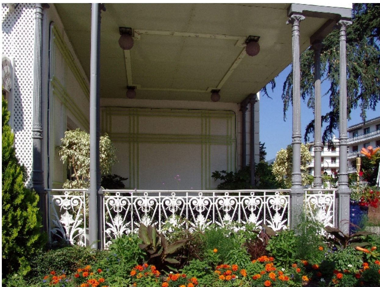
Terrasse du bar sur cour nord
