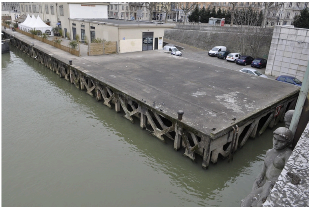
Estacade (détail), vue sud
